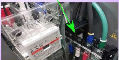
制御盤の500Aの電流センサ
