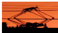
架線摩耗管理
