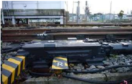
電車通過回数、 レール損傷 管理
