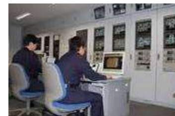
コントロールセンター
