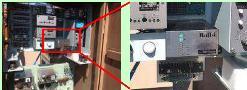
踏切器具箱内のユニバーサルラインのユニットと施工模様
