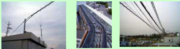
屋外配線と施工の模様
