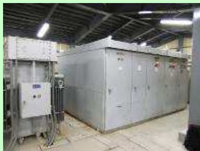
変電所の受電電圧
