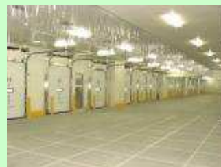
食品冷凍庫・冷蔵庫・冷却庫(温度・故障)
