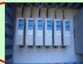
分電盤内のユニバーサルラインのユニット設置の模様
